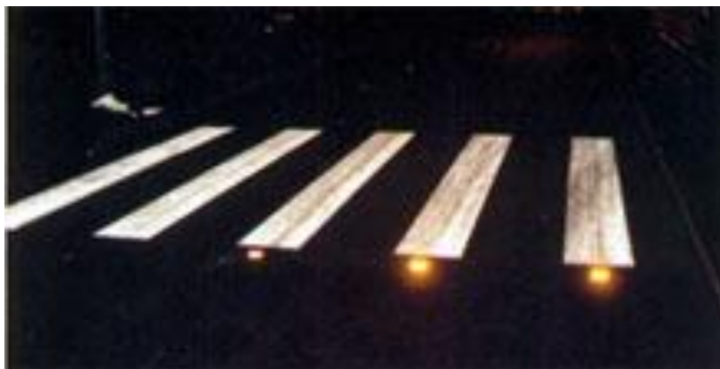
Рисунок 38– Световозвращатели на пешеходном переходе.
