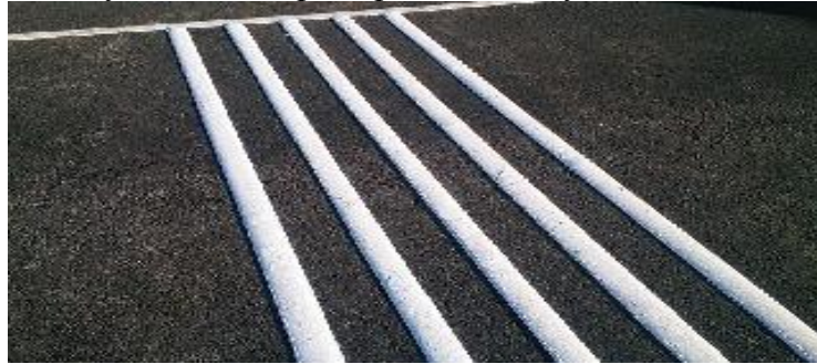
Рисунок 29. Шумовая полоса из термопластика
