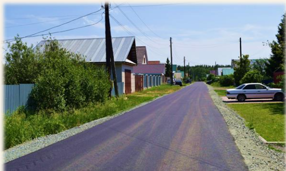
Ремонт дороги по ул.Новая в п.Пригородный
