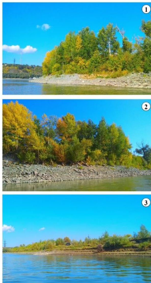
Рисунок 18. Негативные тенденции русловых переформирований р. Обь на территории г. Барнаула. Участок русла в районе городского водозабора №1. Фото 1 – поврежденный участок берегозащитного сооружения. На заднем плане – земснаряд, расчищающий подходной канал к ковшу водозабора. Фото 2 – фрагмент поврежденного участка берегозащитного сооружения. Фото 3 – неукрепленный, размываемый берег у верхнего фланга берегозащитного сооружения
