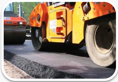
Дороги и сооружения на них
