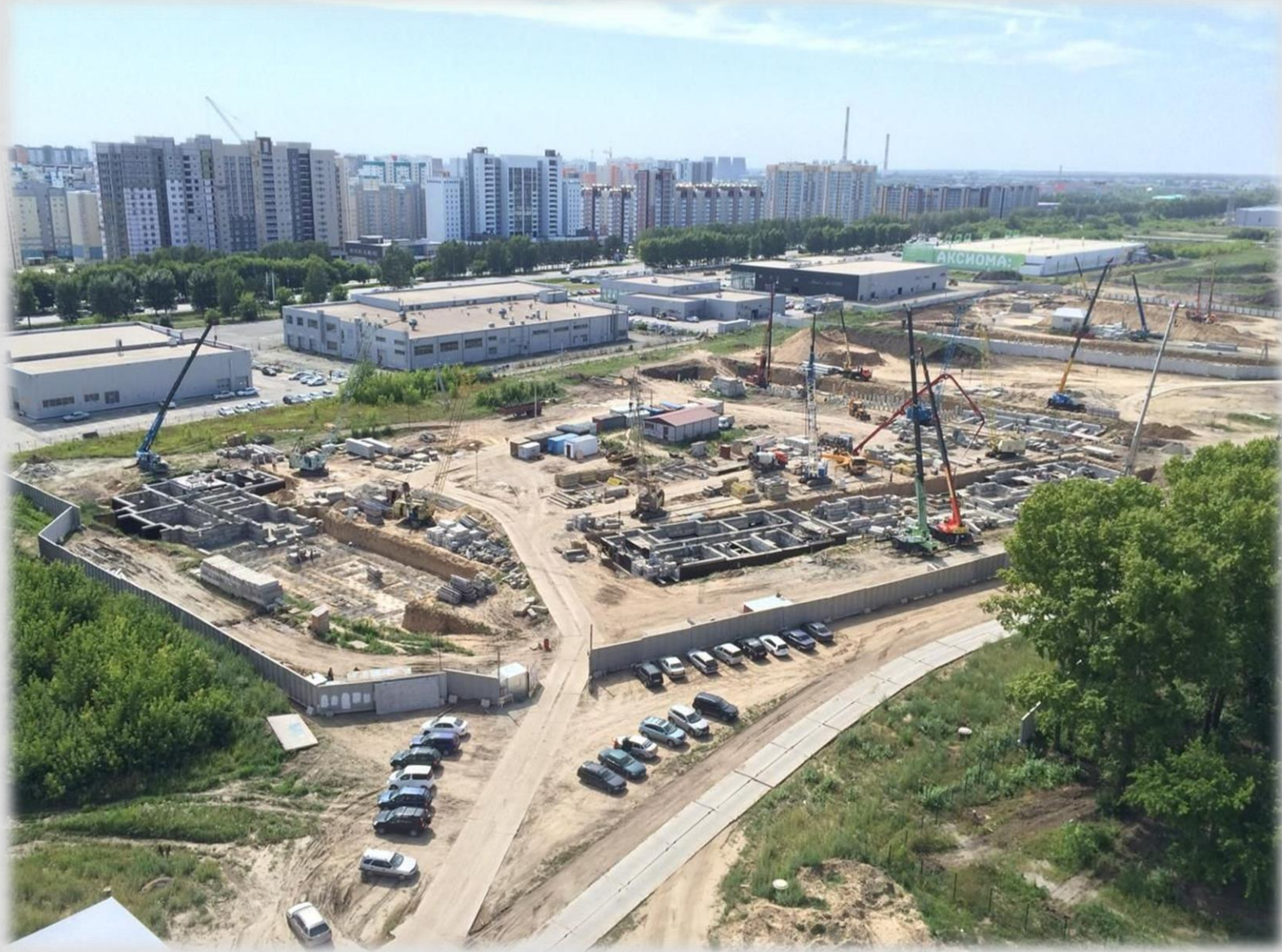
Общий вид начального этапа строительства жилого комплекса «Питер» по ул. 65 лет Победы (вид сверху), 15 августа 2019 г. (АО. Коллекция фотодокументов. Оп. 5. Д. 781)
