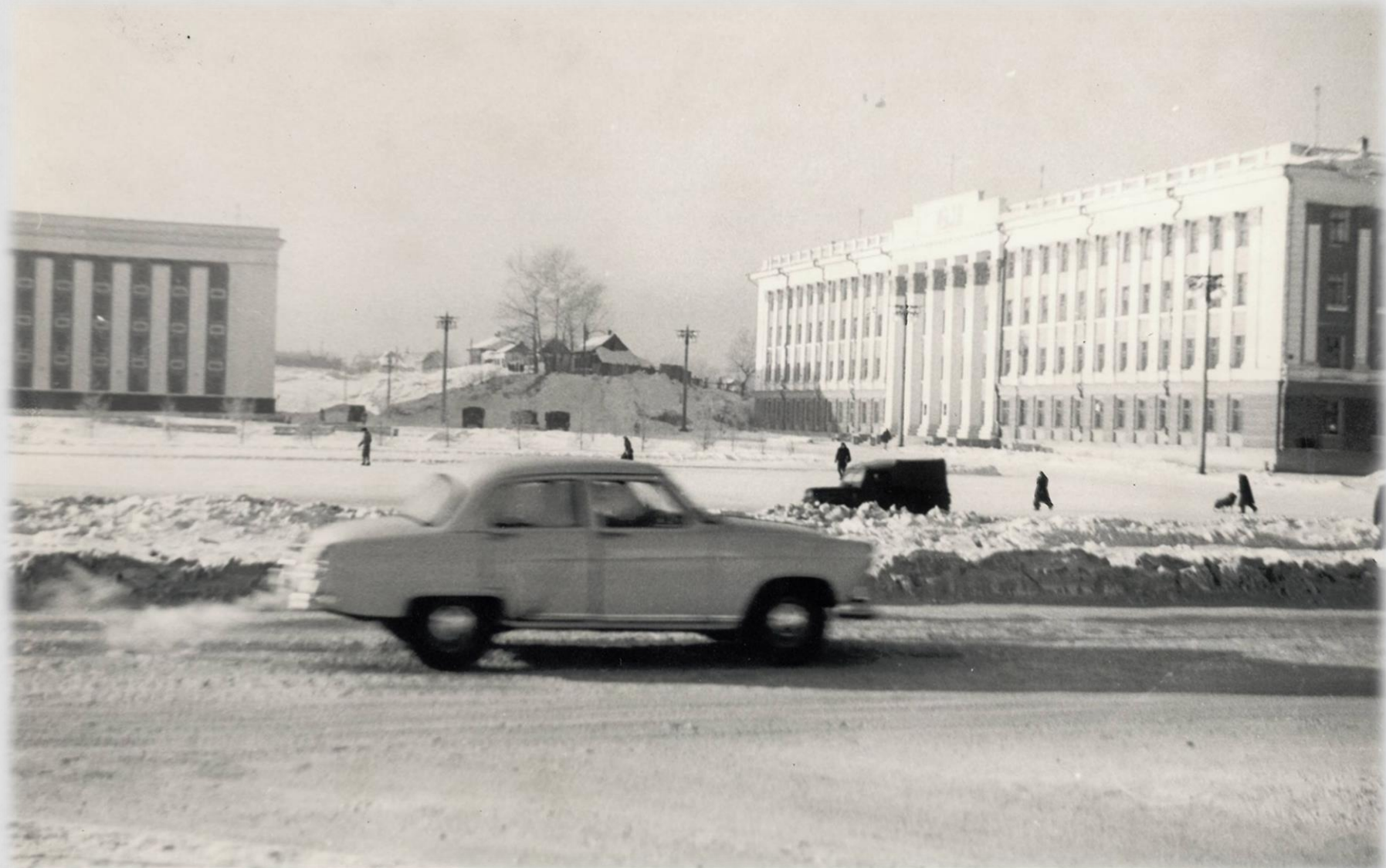
Общий вид с проспекта Ленина на площадь Советов, здания исполнительного комитета Алтайского краевого Совета депутатов трудящихся, Алтайского государственного университета и площадку для строительства драматического театра, 1961 г. (АО. Коллекция фотодокументов. Оп.1. Д.297)
