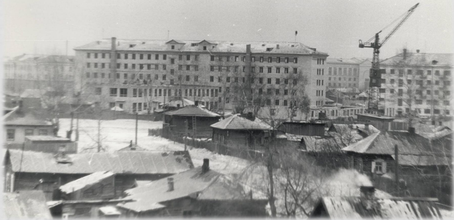
Строительство новых жилых зданий на пересечении улиц Брестской и Деповской, 1963 г. (АО. Коллекция фотодокументов. Оп.1. Д.315)
