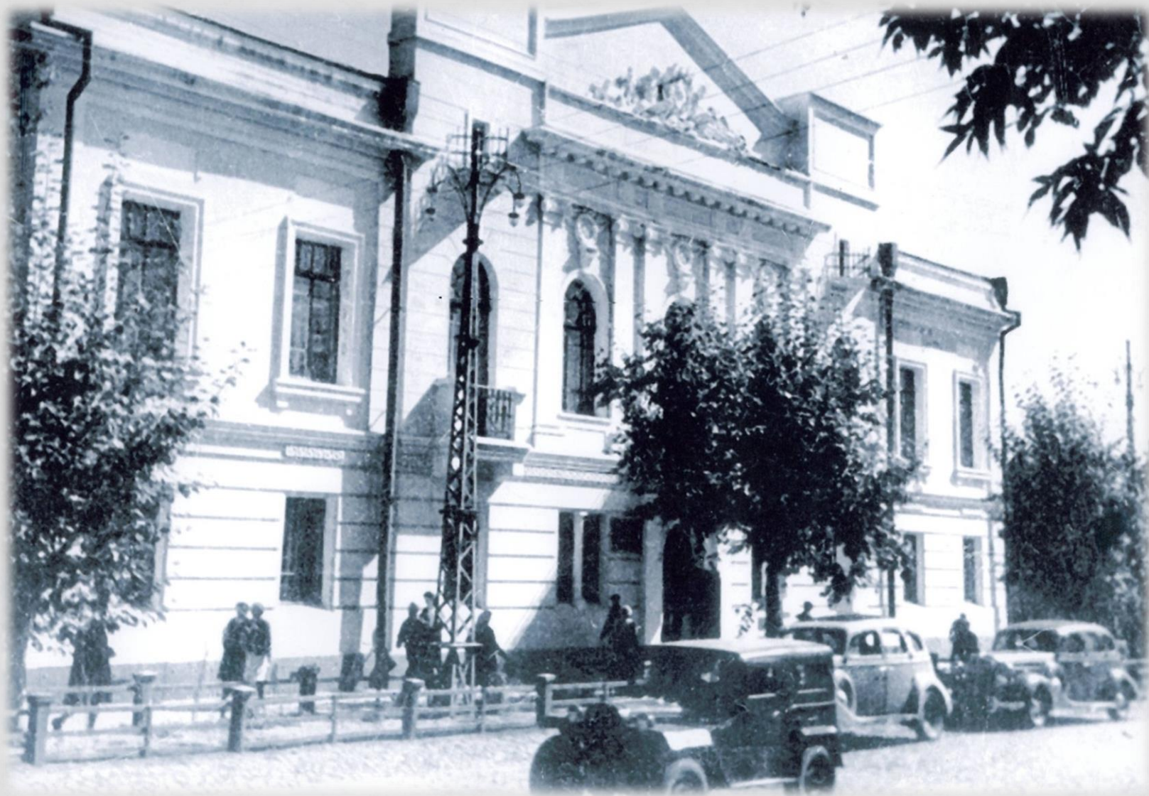
Общий вид дома начальника Алтайского горного округа, построенного архитектором Я.Н. Поповым в 1840 г., в 1948 г. в нем располагался городской исполнительный комитет Совета депутатов трудящихся, в настоящее время - здание администрации города Барнаула, 1948 г. (АО. Коллекция фотодокументов. Оп.1. Д.286)
