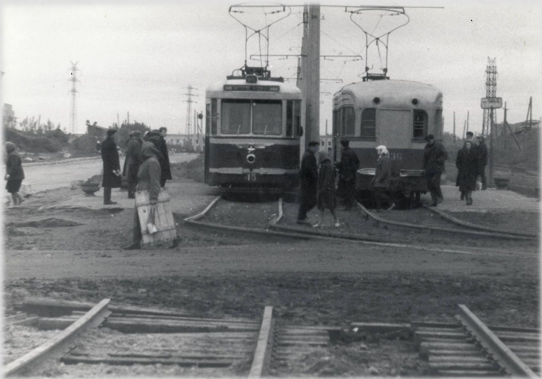
Укладка трамвайного полотна по проспекту Ленина, 1962 г. (АО. Коллекция фотодокументов. Оп.1. Д.308)
