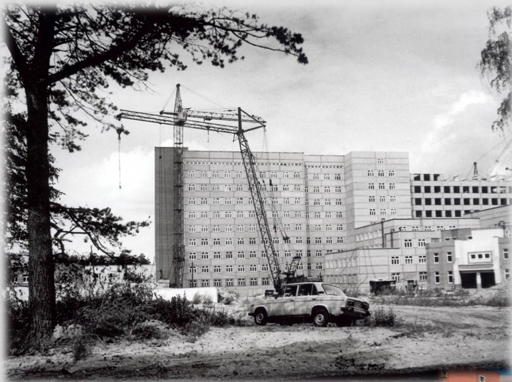
Ход строительства новых корпусов Алтайской краевой больницы в нагорной части леса, 1998 г. (АО. Коллекция фотодокументов. Оп.1. Д.53)
