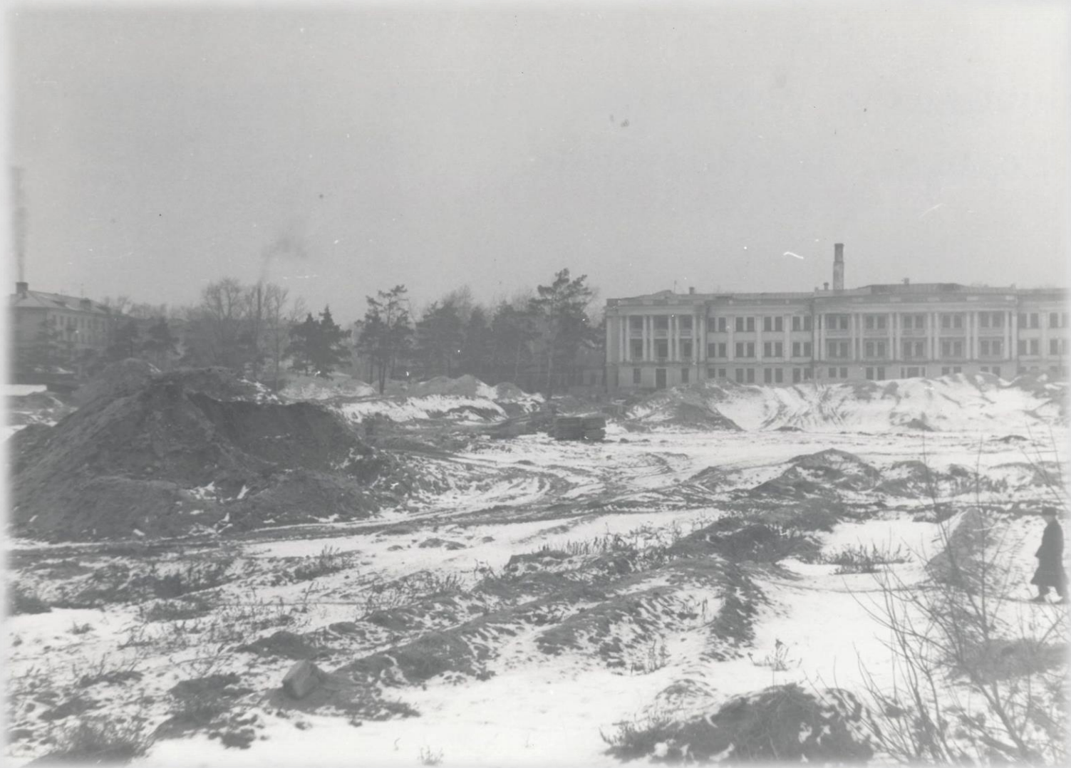
Общий вид здания хирургического корпуса городской больницы и строительной площадки под корпуса политехнического института, 1963 г. (АО. Коллекция фотодокументов. Оп.1. Д.312)
