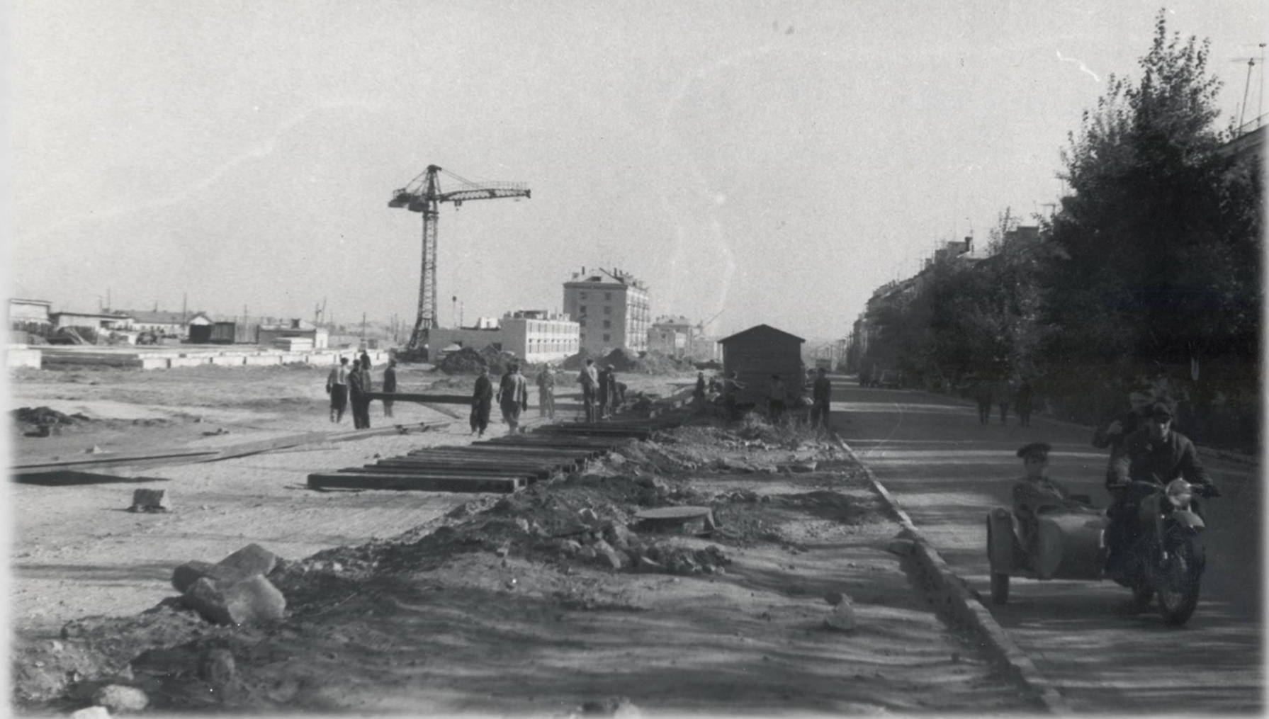
Укладка трамвайного полотна по проспекту Ленина, 1962 г. (АО. Коллекция фотодокументов. Оп.1. Д.307)
