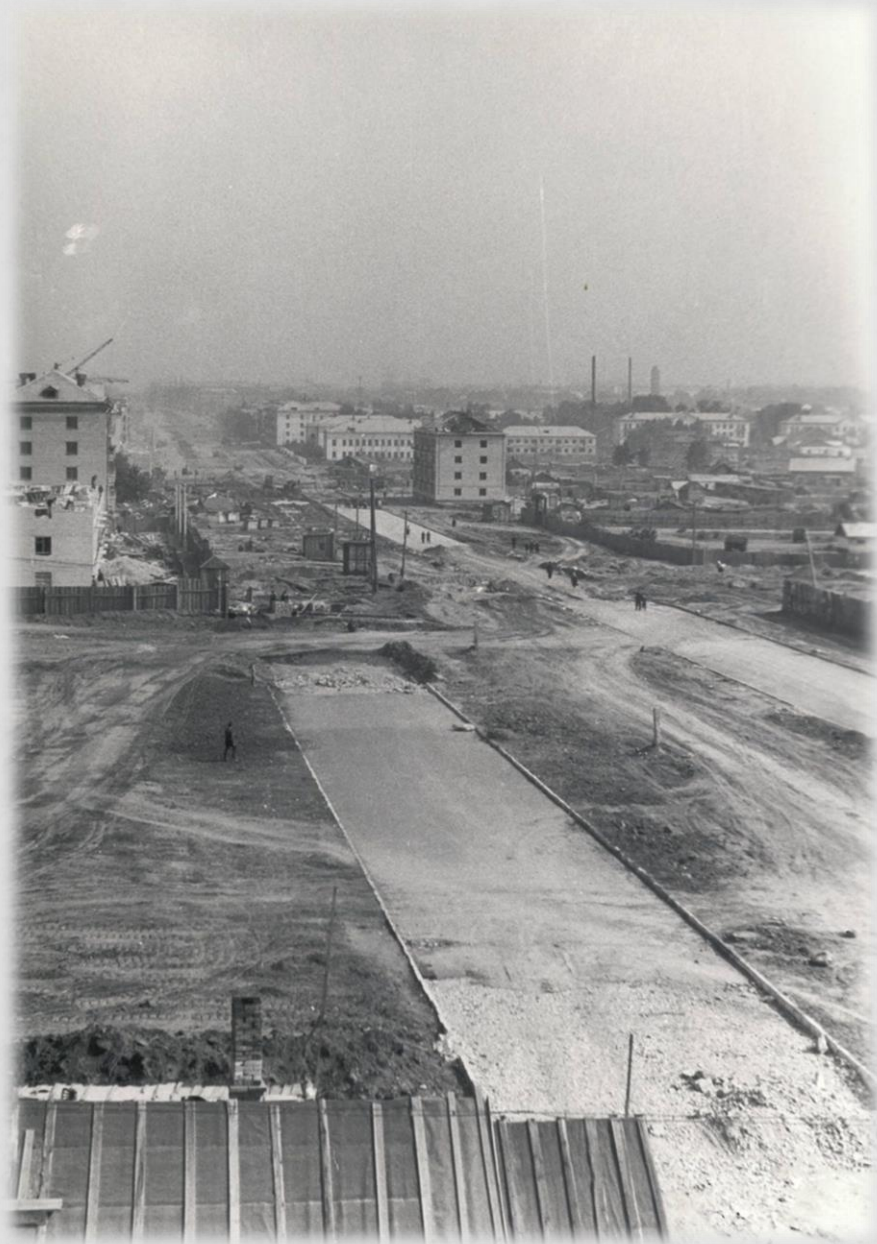
Застройка проспекта Ленина на пересечении с улицей Северо-Западной. Общий вид в сторону Машиностроительного техникума, улицы Матросова, 1961 г. (АО. Коллекция фотодокументов. Оп.1. Д.301)
