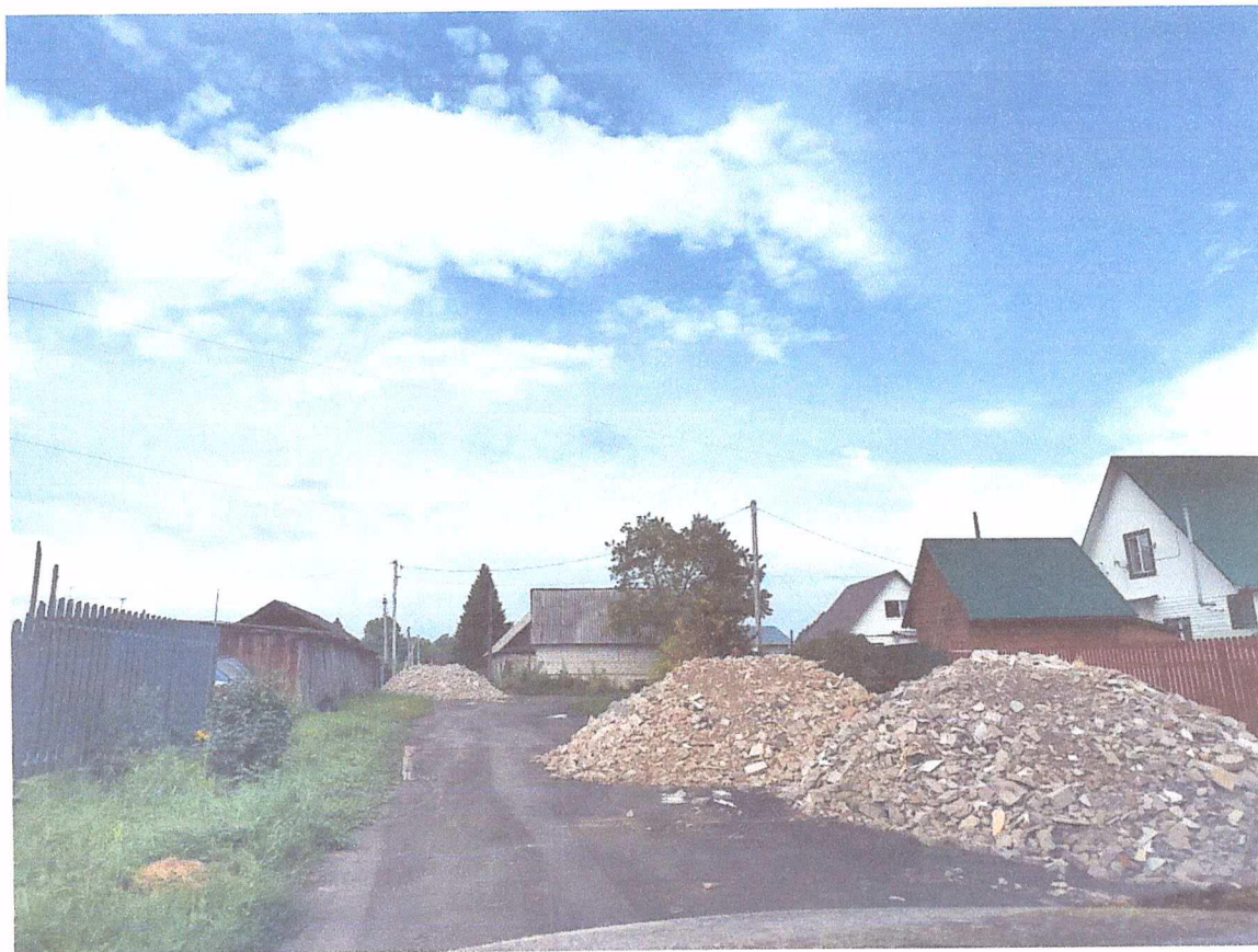
Отсыпка дороги силами и средствами самих жителей улицы.
