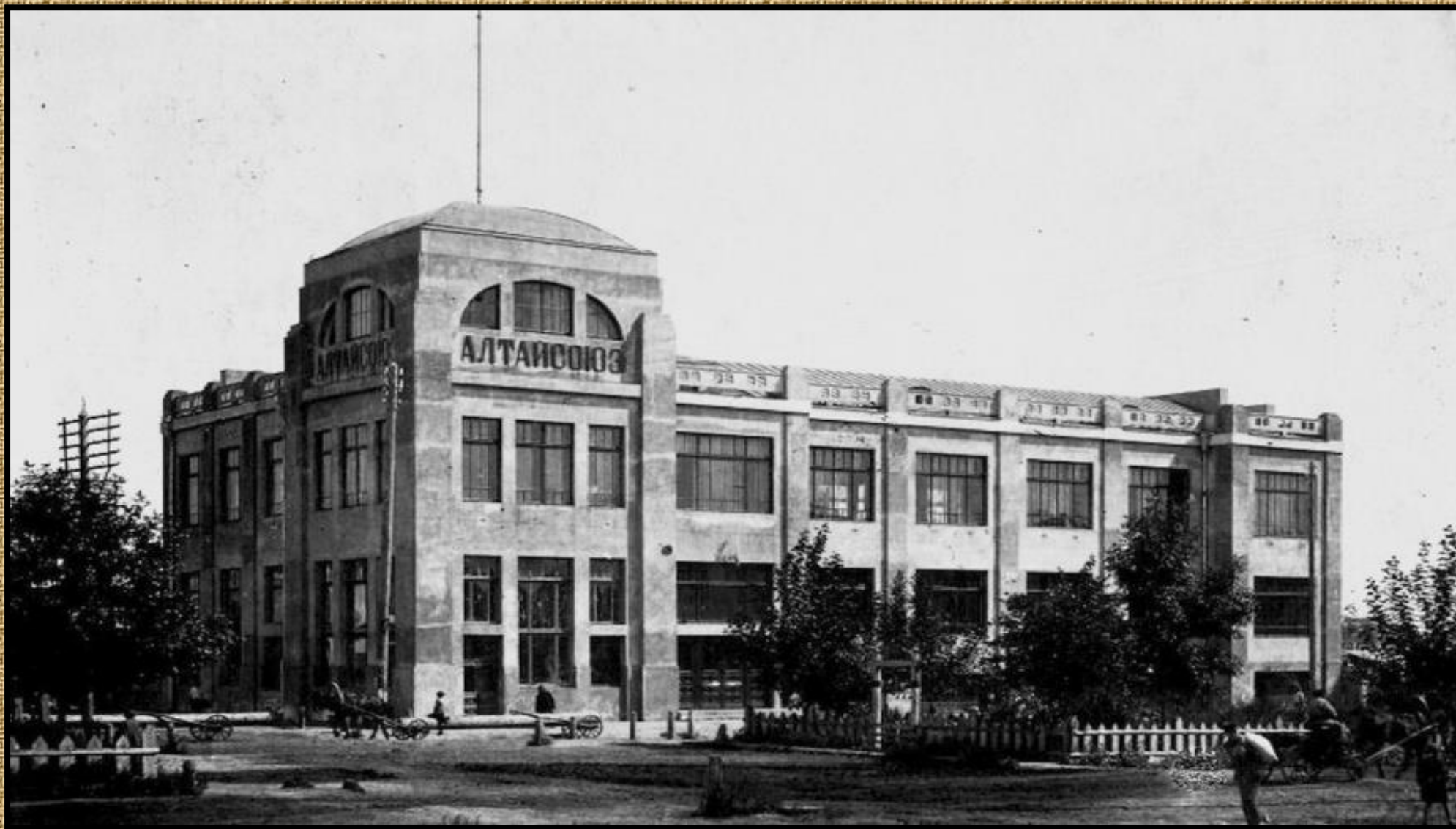
В 1929 г. на пересечении проспекта Ленина и ул.Пушкинской построено административное здание Алтайсоюза
