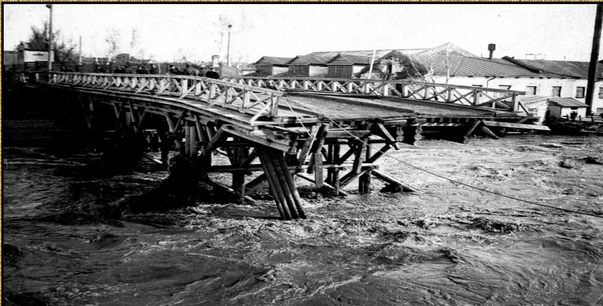
Паводок на р.Барнаулке в Барнауле. Май 1937 года
