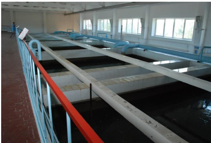
Зал фильтров очистных сооружений
