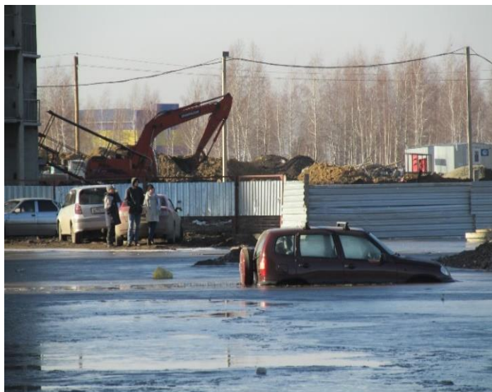
Подтопление паводковыми водами
