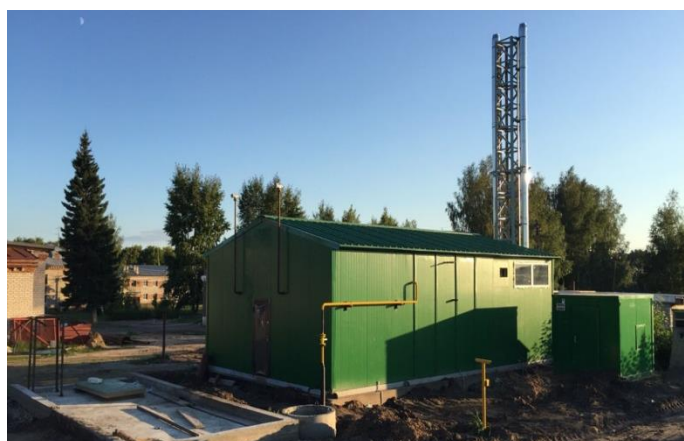
Газовая котельная в п.Лесной
