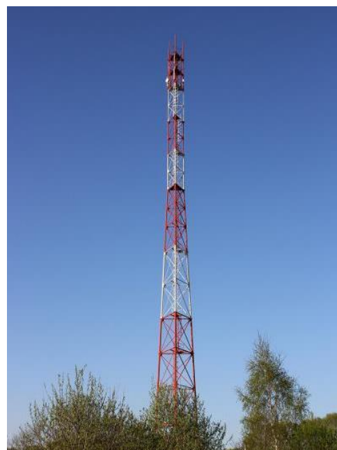
Базовая станция сотовой связи
