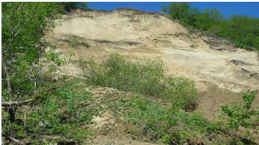
Участок ул.Фабричная, 26, оползневые явления. Октябрьский район
