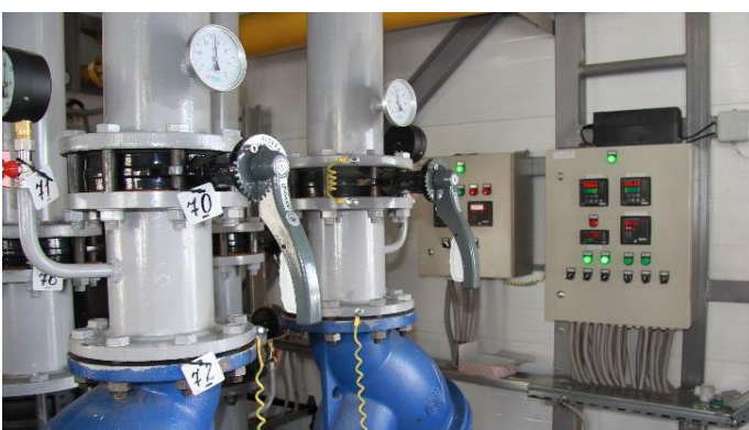
Газовая блочно-модульная котельная АО «Алтайский шинный комбинат»
