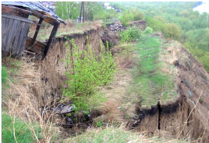
Проседающий оползневой блок по ул. Якутская, 1. Центральный район
