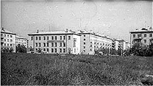
Панорама жилых домов на Потоме. 1968 г. ГААК. Фотонегатив 0-1915.
