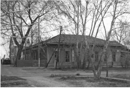
Здание ДХШ (Аванесова, 30, 1990-е гг.)
