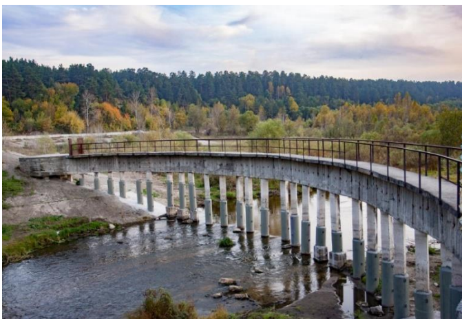
Гидротехническое сооружение на р. Барнаулка
