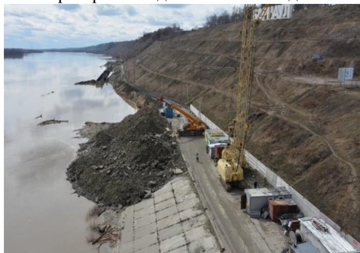
Строительство набережной р.Обь
