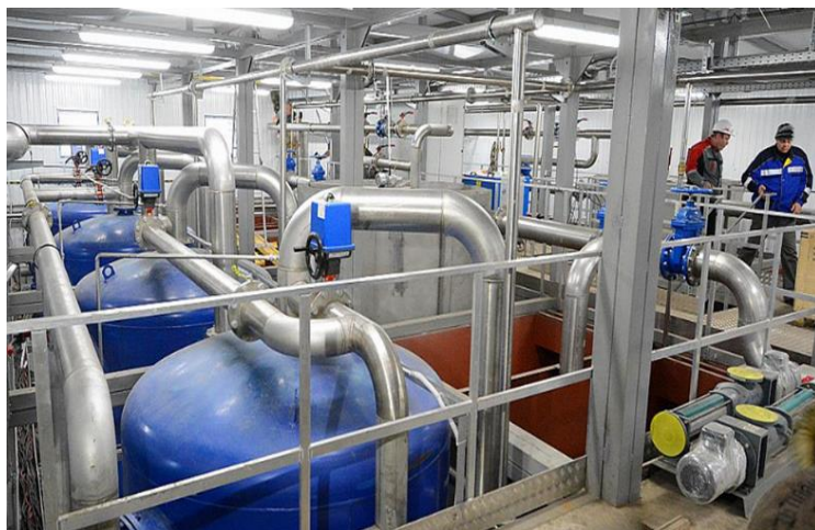
Очистные сооружения на ул.Чехова
