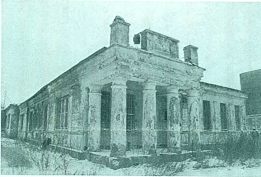
Фото 1 от 24.11.2015. Общий вид. Главный юго-восточный фасад и юго-западный фасад.
