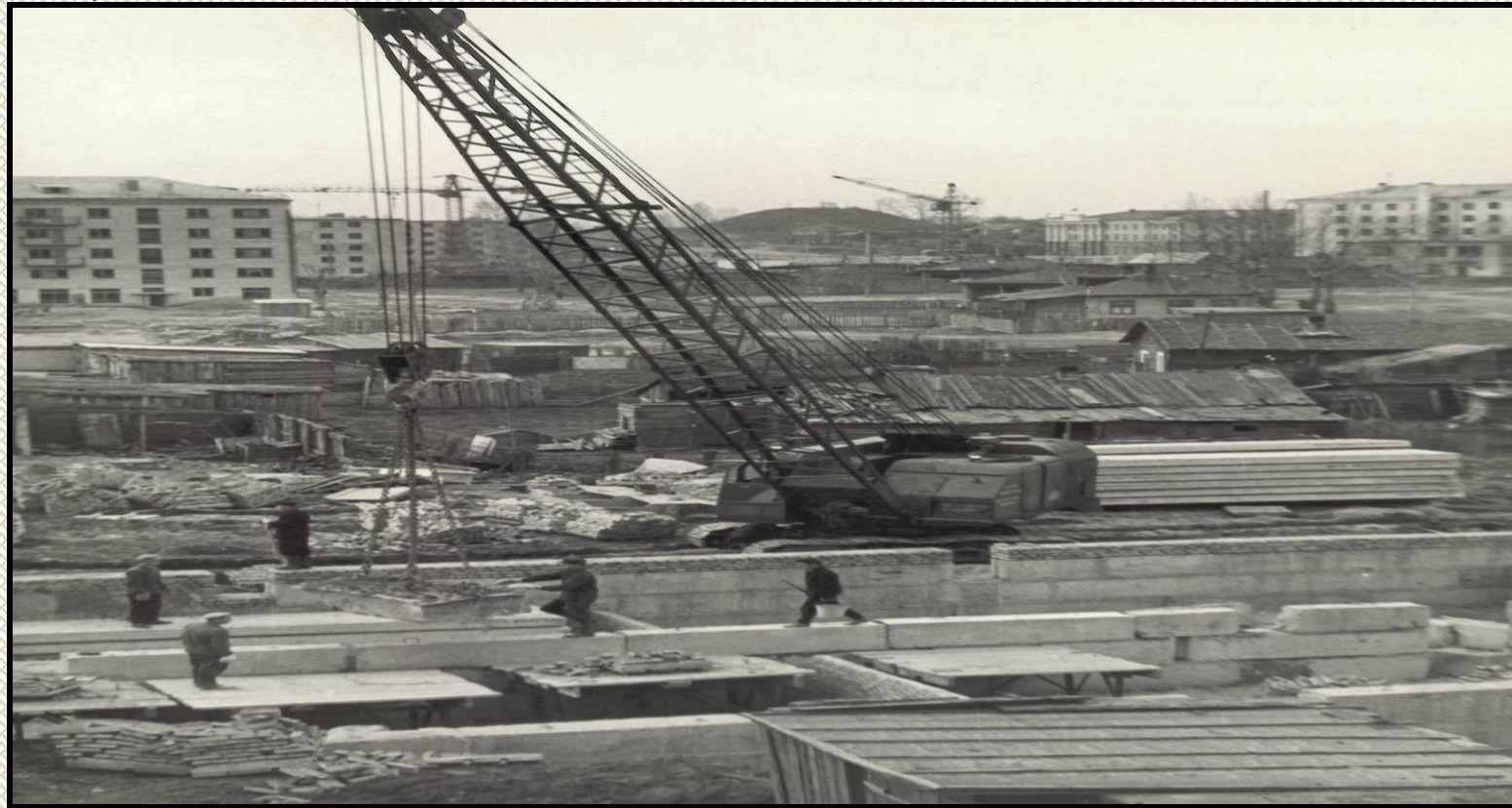
Общий вид начала строительства по улице Брестская. 1964 г.
