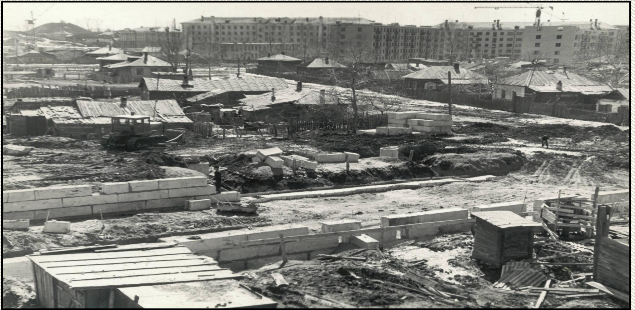
Общий вид начала строительства по улице Брестская. 1963-1964 г.
