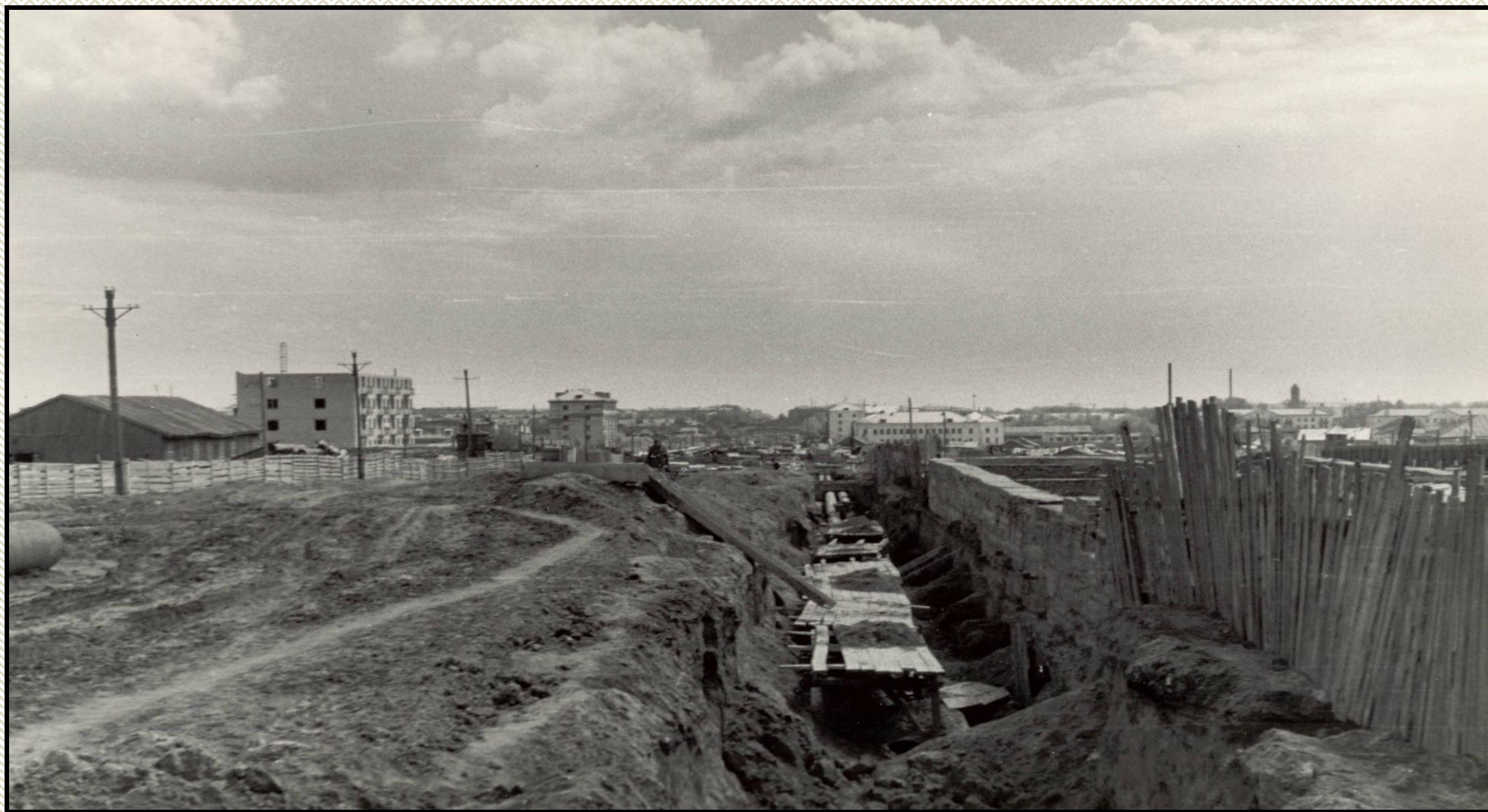
Строительство теплотрассы на пересечении проспекта Ленина и улицы Северо-Западной. 1961 г.
