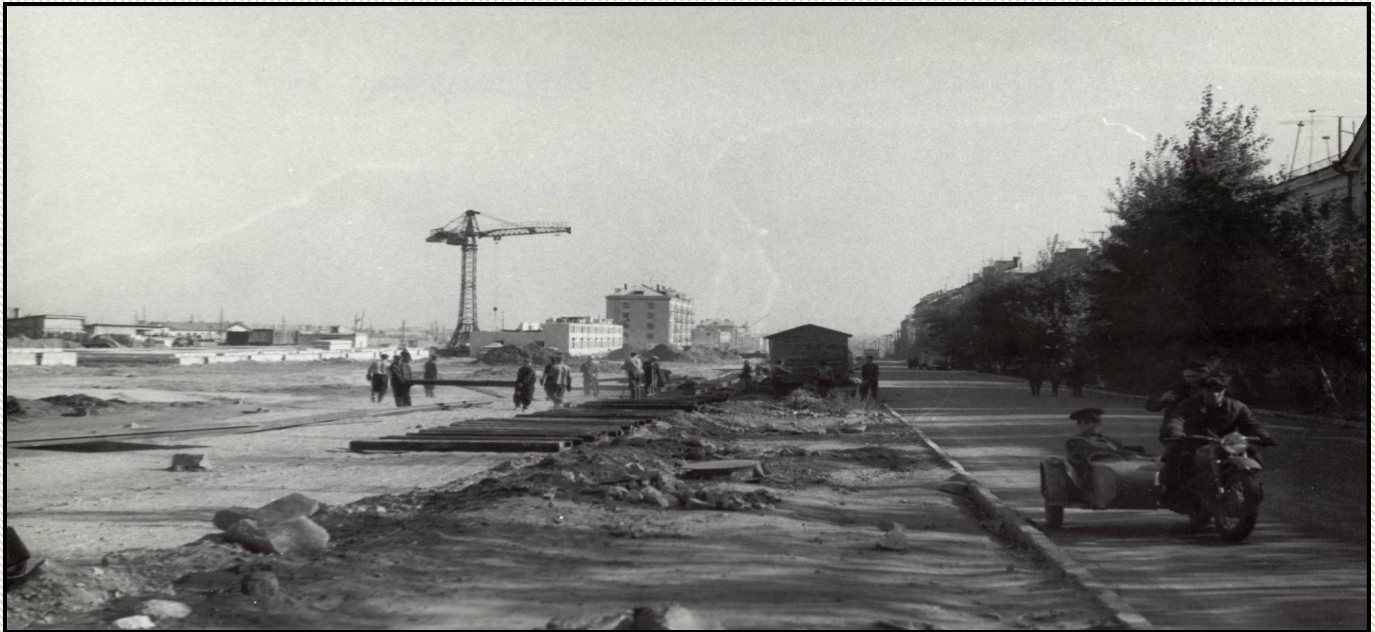
Укладка трамвайного полотна по проспекту Ленина между улицами Чеглецова и Северо-Западной. 1962 г.
