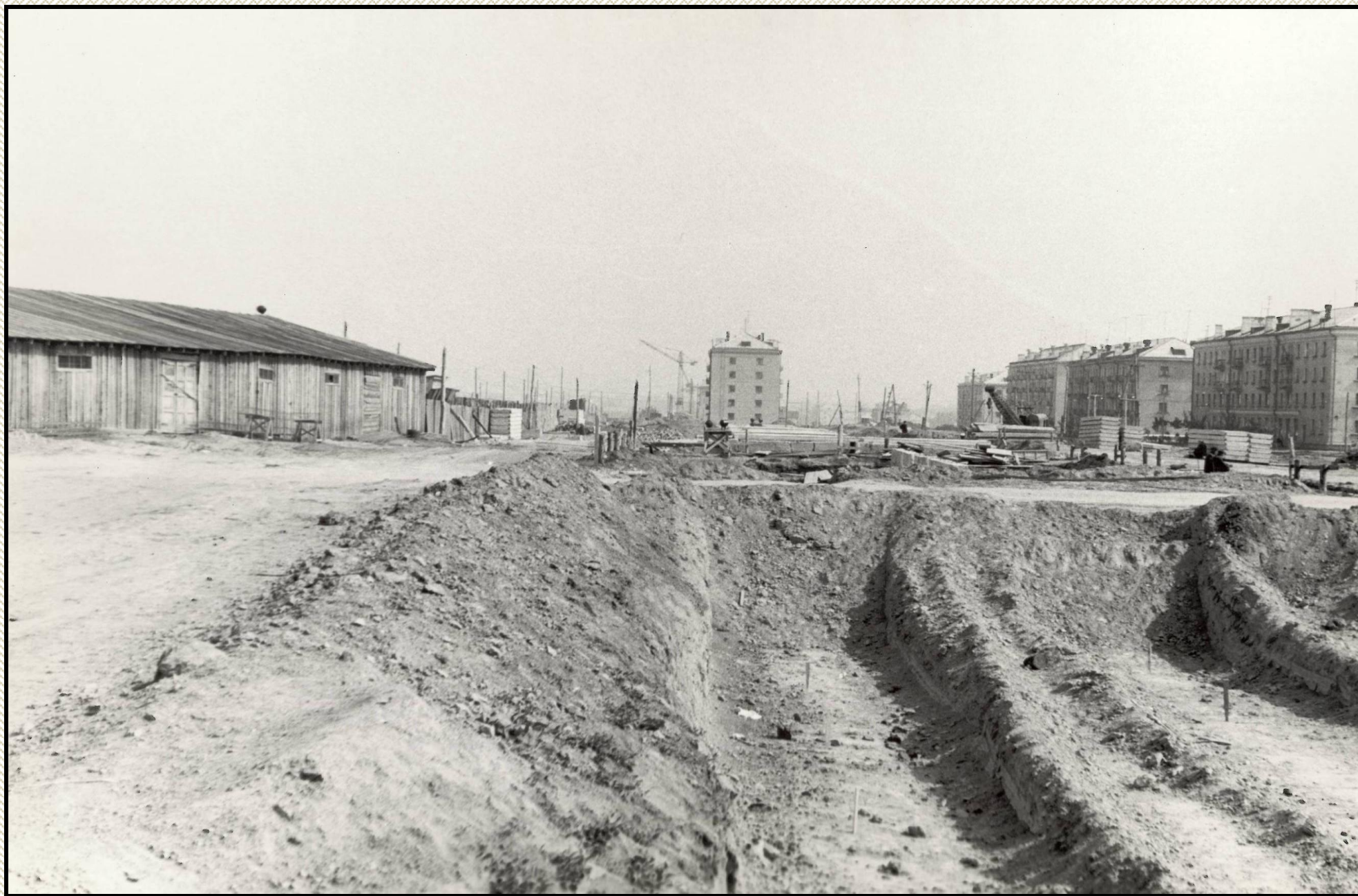
Строительство теплотрассы на пересечении проспекта Ленина и улицы Северо-Западной. 1961 г.
