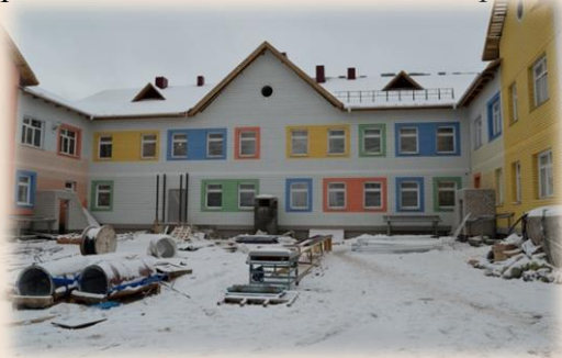
Строительство детского сада в квартале 2008
